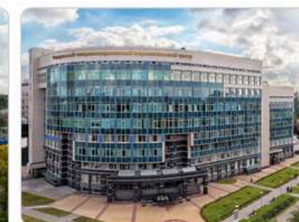
Перинатальный центр ул. Аккуратова, д. 2 лит. Б 173 койки
